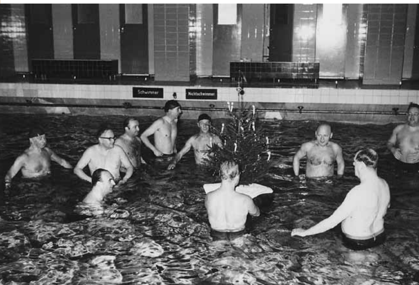
Gerüstkonstruktion \ Damenbad - Foto: Peter Gauditz Goseriadebad um 1950 - Foto: kestnergesellschaft
